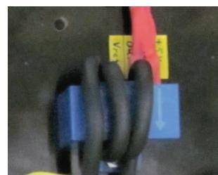
Obrázek 4.2: Uchycení LEM sondy v rozvaděči
