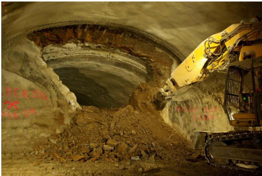
Obrázek 2.2: Prorážka severního tubusu tunelového úseku Brusnice,
