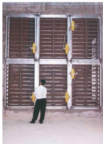
Obrázek 3.5: Soustava uzavíratelných klapiek sloužících pro převod vzduchu mezi tubusy [1].
