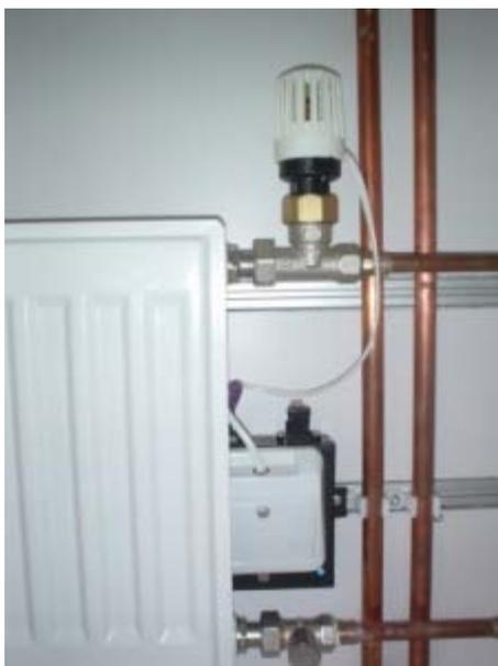
Obrázek 8: Fotografie vytvořeného nodu s termohlavicí
